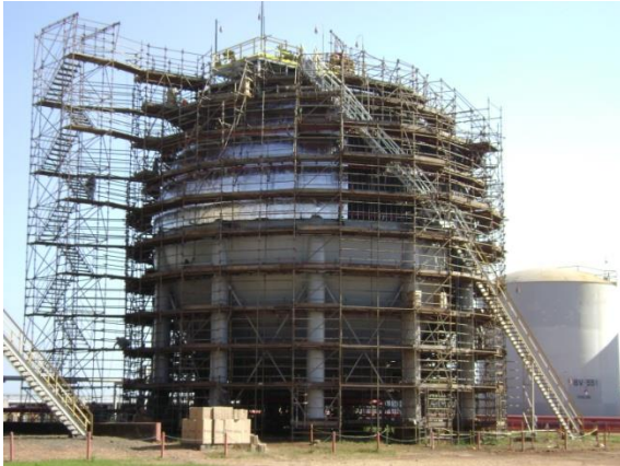
Foto 1 – Andaime instalado da empresa industrial Fonte: Própria
