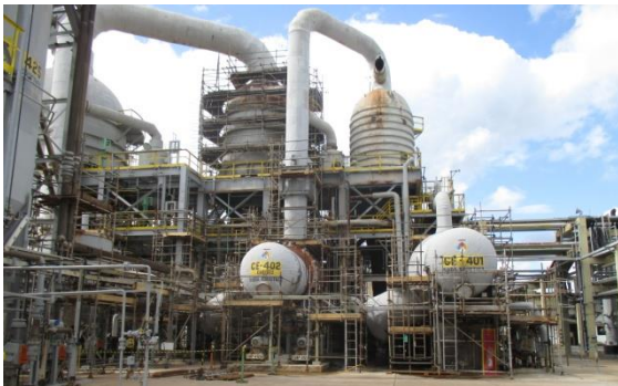
Foto 2 – Andaime instalado da empresa industrial Fonte: Própria
