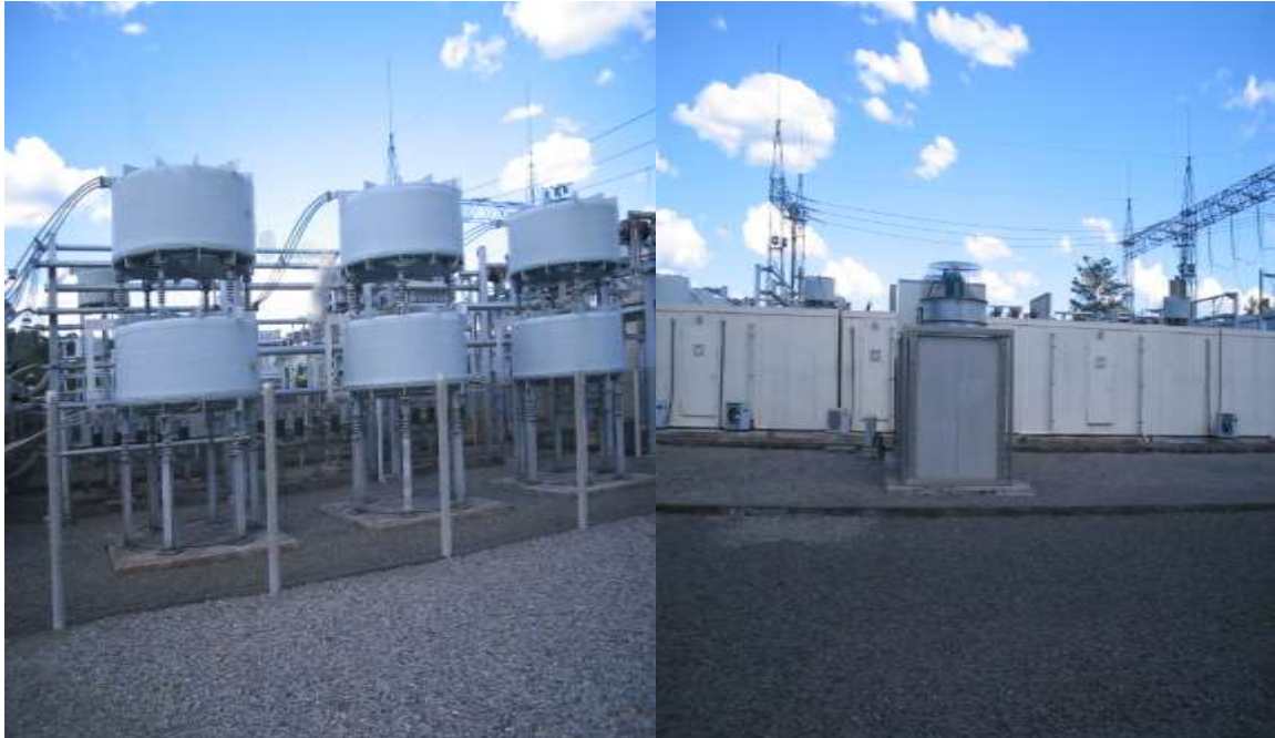
Figura 06 Compensador Estático (CE)
