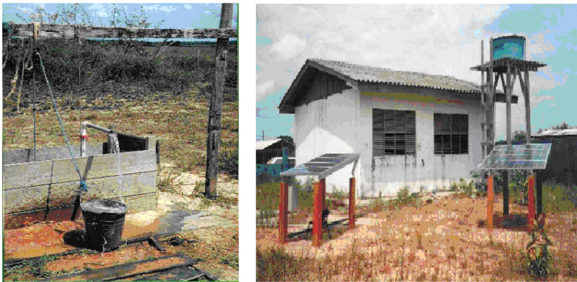
Figura 7- bombeamento de um poço. Fonte: CEPEL
