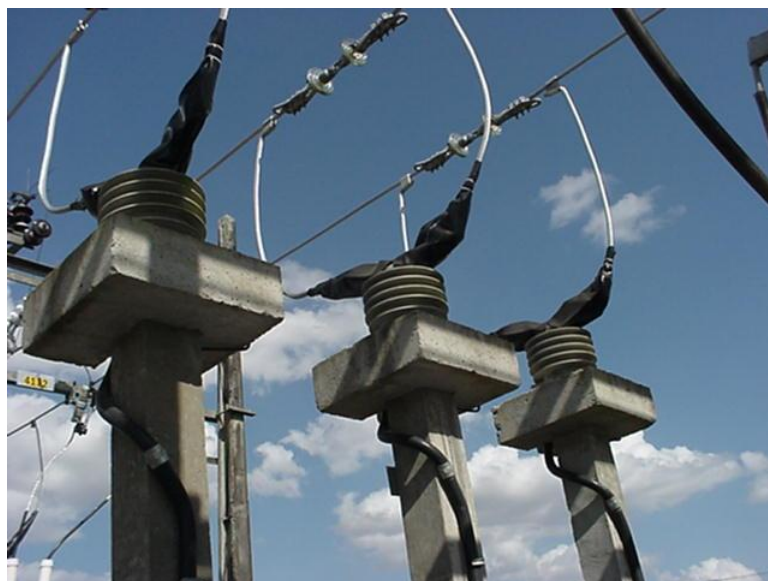
Figura 2.3 - Transformador de Corrente
