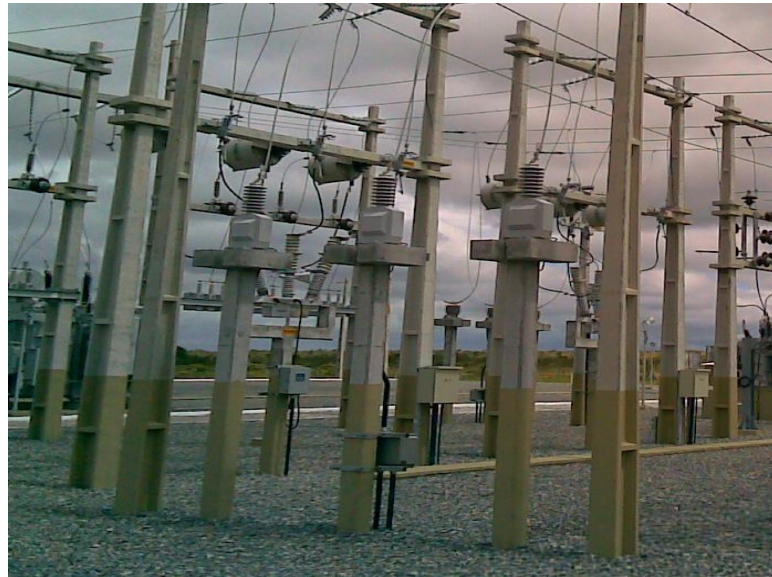
Figura 2.4 - Transformador de Potencial
