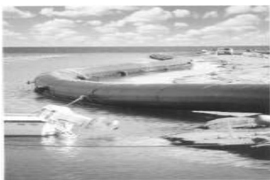
Figura 6 a) Assentamento sinuoso de tubos de PE
