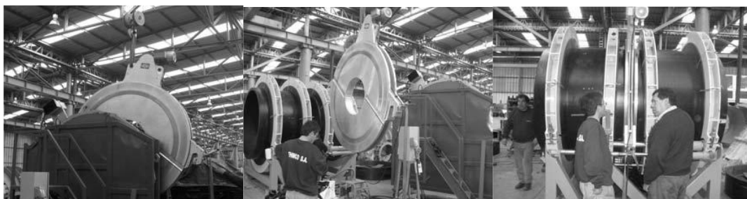
Figura 13 – Colocação do faceador para nivelamento das faces a serem soldadas
