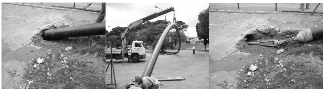
Figura 7 – Inserção de tubos por furo direcional
