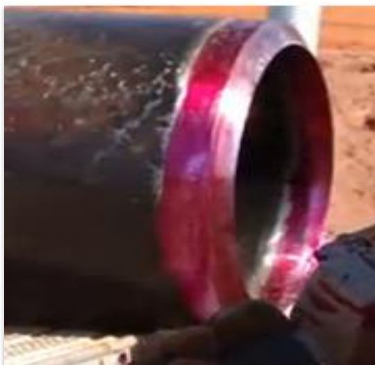
Figura 47 – Proteção do bisel com antioxidante.
