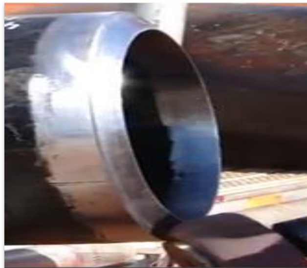
Figura 45 – superfície da junta preparada para ser soldada.
