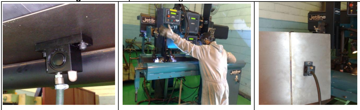
Figura 33 - Etapas de soldagem com o vibrador mecânico
