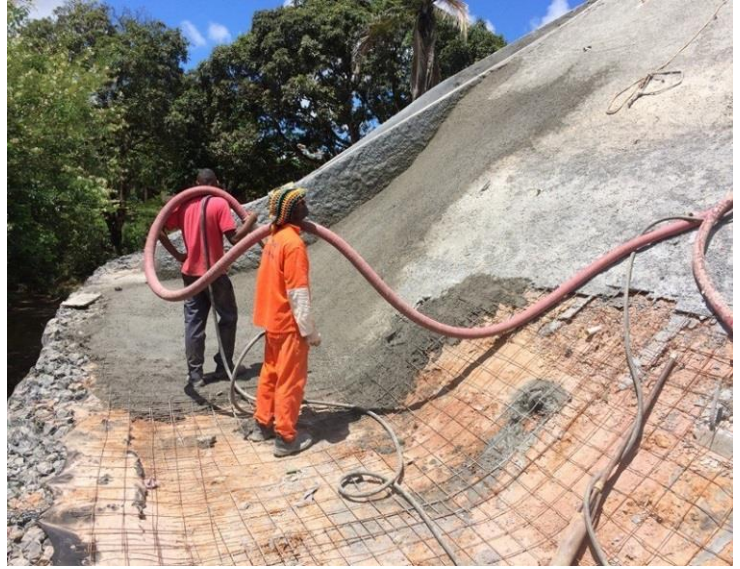
Figura 76 – Execução do concreto projetado e cura do solo-grampeado no talude.
