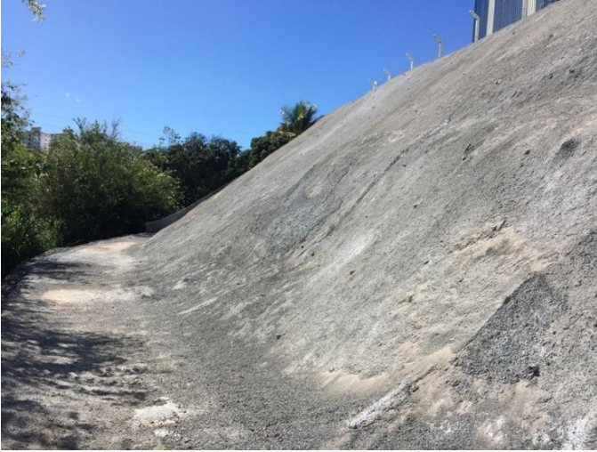
Figura 77 – Solo-grapeado finalizado.
