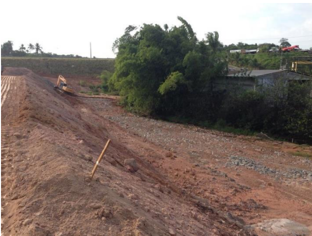
Figura 47 – Lançamento de pedra marroada – Reforço do terreno no trecho alagado, à margem do rio.
