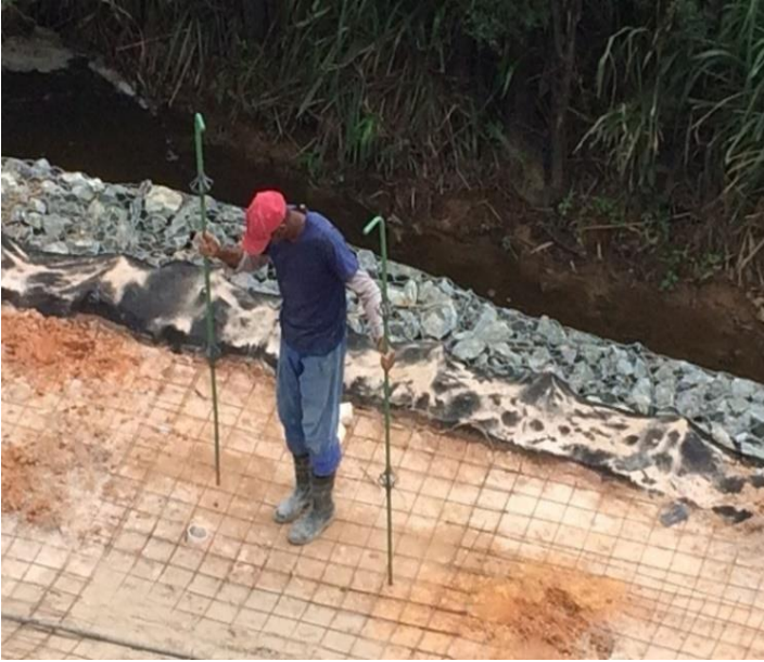
Figura 73 – Instalação dos grampos de aço no talude com suas devidas presilhas.
