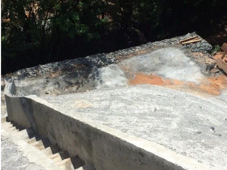
Figura 72 – Conclusão de uma escada drenante.
