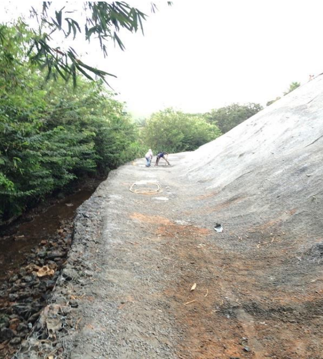
Figura 79 – Solo-grapeado e gabião finalizados - Vista da base do talude.
