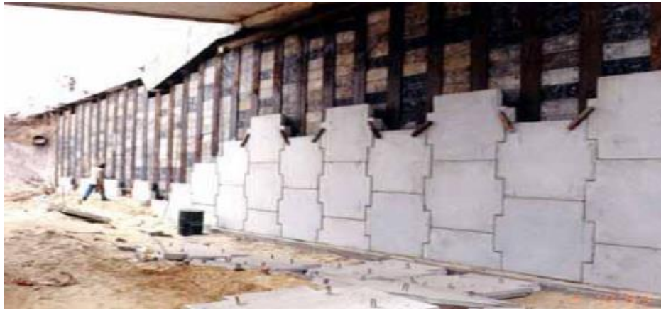
Figura 17 – Sobreposição das “escamas” no paramento externo (MAPARAGEM, 2012).
