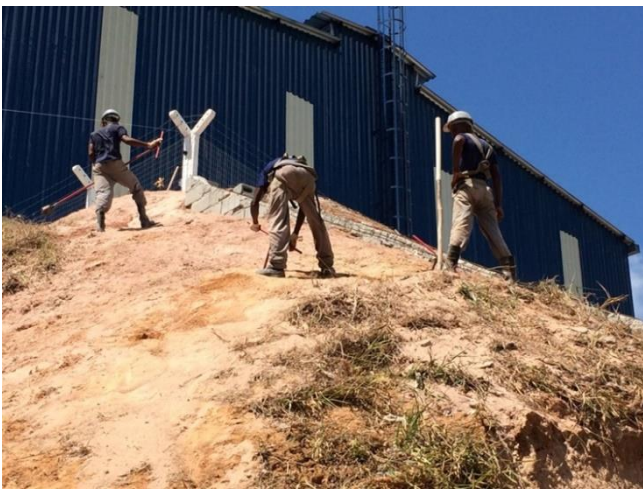
Figura 70 – Execução de abertura dos furos dos grampos no talude.
