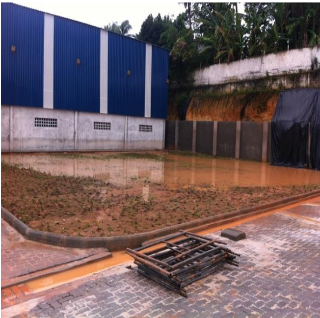
Figura 58 – Canteiro do galpão alagado - Causa da erosão das Figuras 56 e 57.
