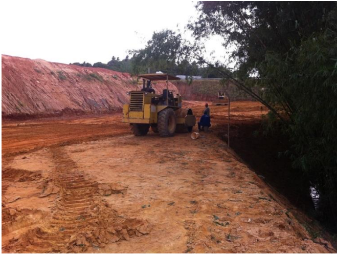
Figura 51 – Execução do aterro compactado - A esquerda observa-se uma parte do aterro mais avançado.
