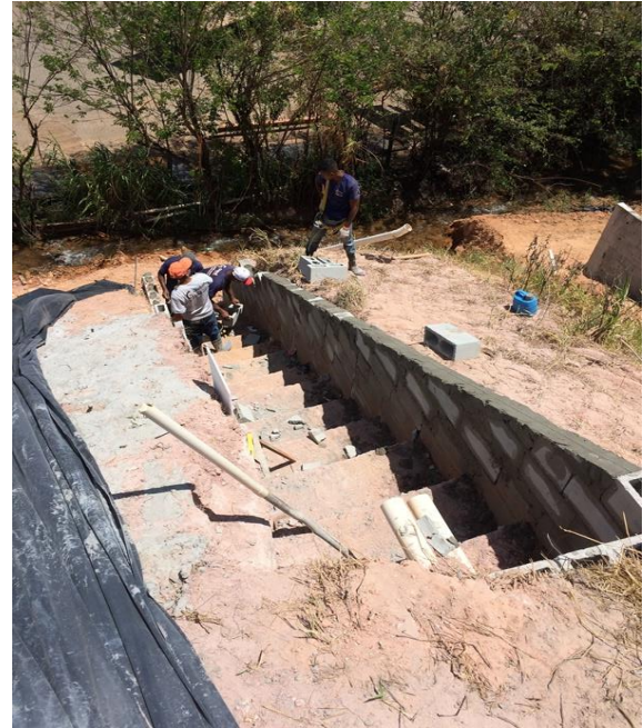
Figura 61 – Construção de outra escada drenante no talude.
