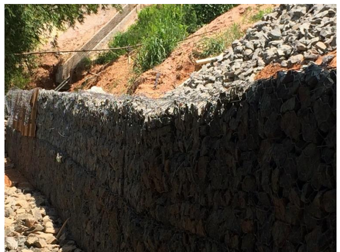
Figura 69 – Evolução da construção do gabião caixa.
