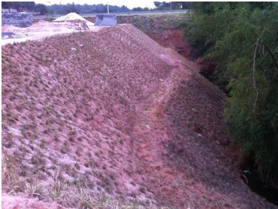
Figura 53 – Talude construído a partir do aterro compactado - Situação antes da instabilidade.
