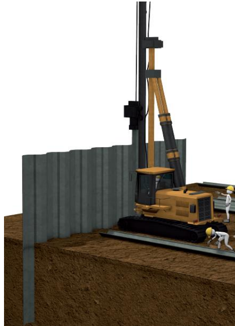
Figura 19 – Contenção em estaca-prancha (PINI, 2011).
