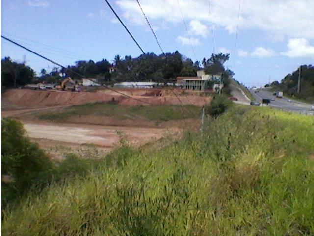
Figura 29 – Linhas de alta tensão de energia elétrica atravessando o terreno.
