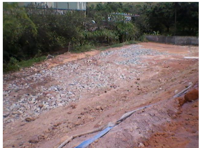
Figura 48 - Lançamento e compactação de lastro de pedra marroada – Continuação do reforço do terreno no trecho alagado, à margem do rio.
