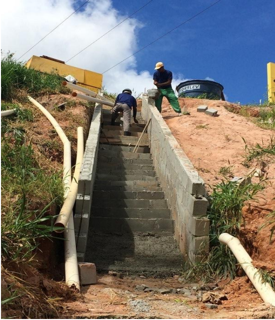
Figura 60 – Construção de uma das escadas drenantes do talude.
