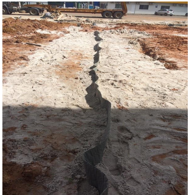
Figura 59 – Instalação de drenos sub-superficiais na área do canteiro do galpão.
