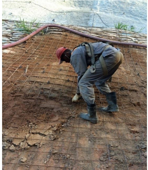
Figura 74 – Instalação das telas de aço na face do talude - Amarração nos grampos já chumbados.
