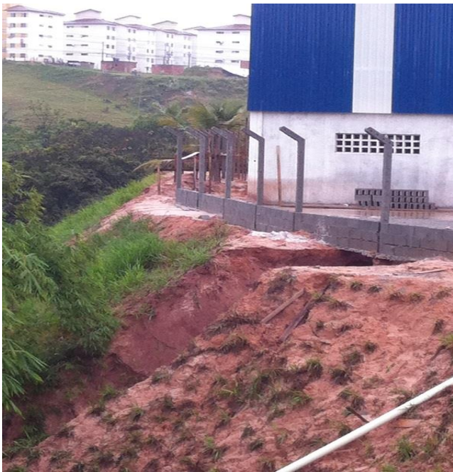
Figura 56 – Erosão em outra área do talude, característico de desprendimento. Figura 57 – Erosão no talude – Vista de cima.
