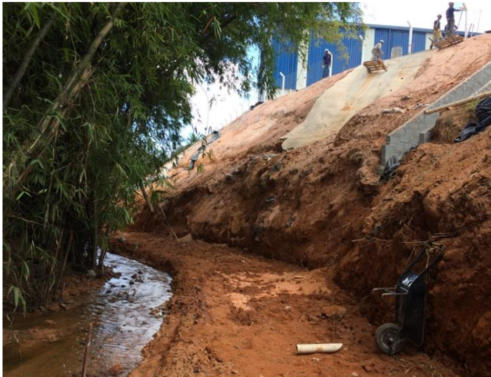
Figura 64 – Retirada de terra ao pé do talude - Largura do rio com 2,0 metros e ao lado largura do lastro da base do gabião 2,50 metros.
