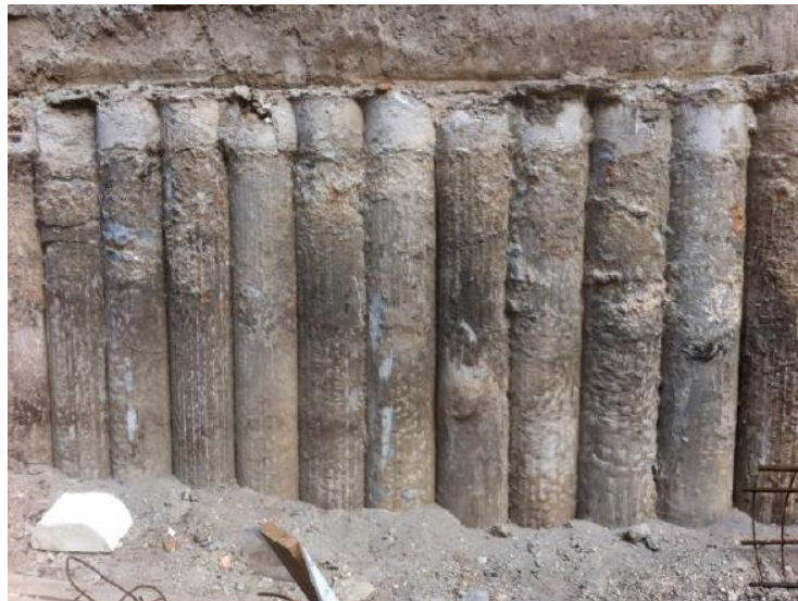
Figura 20 – Contenção em estaca secante (SANGLARD, 2014).
