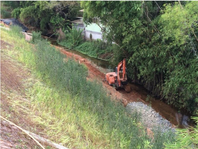
Figura 65 – Execução do lastro de pedra da base do gabião - Largura de 2,50 metros de lastro de pedra para suportar o gabião.
