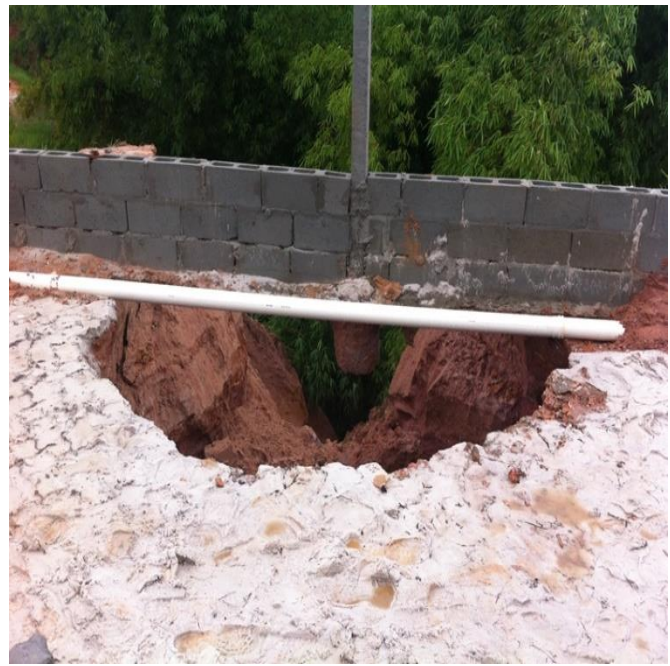
Figura 56 – Erosão em outra área do talude, característico de desprendimento. Figura 57 – Erosão no talude – Vista de cima.
