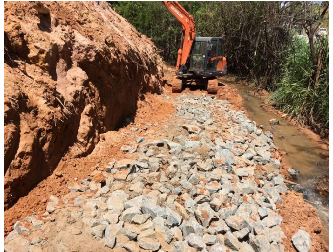
Figura 66 – Espalhamento do lastro de pedra da base do gabião - Largura de 2,50 metros de pedra à margem do rio.
