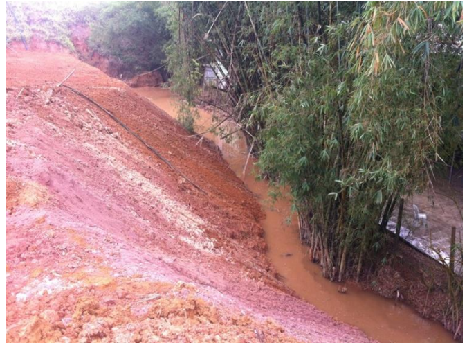
Figura 52 – Evolução do aterro compactado - Verifica-se o talude muito próximo ao rio.
