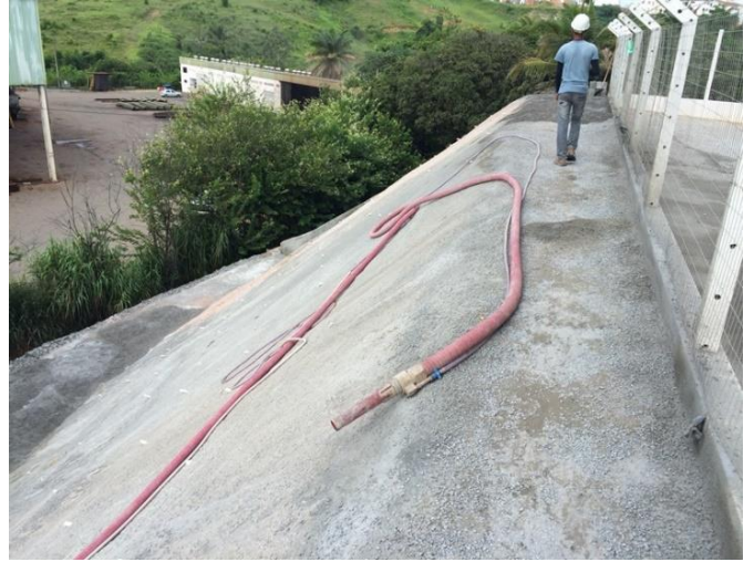
Figura 78 – Solo-grapeado finalizado – Vista da crista do talude.
