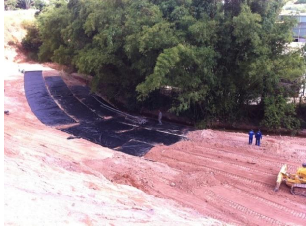
Figura 50 – Aplicação da segunda camada de manta geotêxtil - Intercalando com o aterro compactado.
