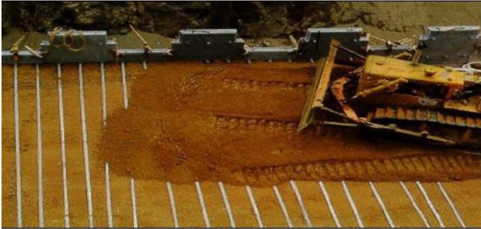
Figura 16 – Disposição das fitas metálicas e aterro compactado (MAPARAGEM, 2012).
