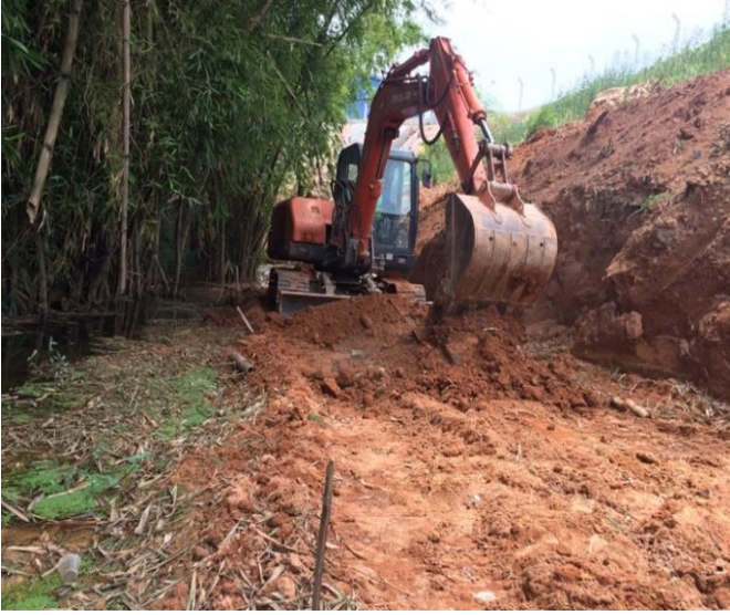
Figura 62 – Corte de terra no pé do talude.
