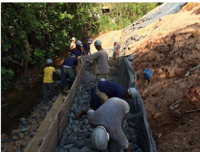
Figura 68 – Início da execução do gabião caixa, no pé do talude.
