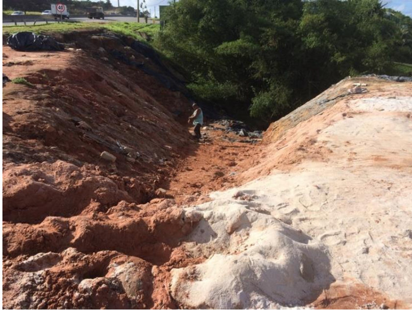
Figura 67 – Criação de acesso entre o talude e a BA-526, dentro do terreno – Acesso para ampliação das frentes de trabalho.
