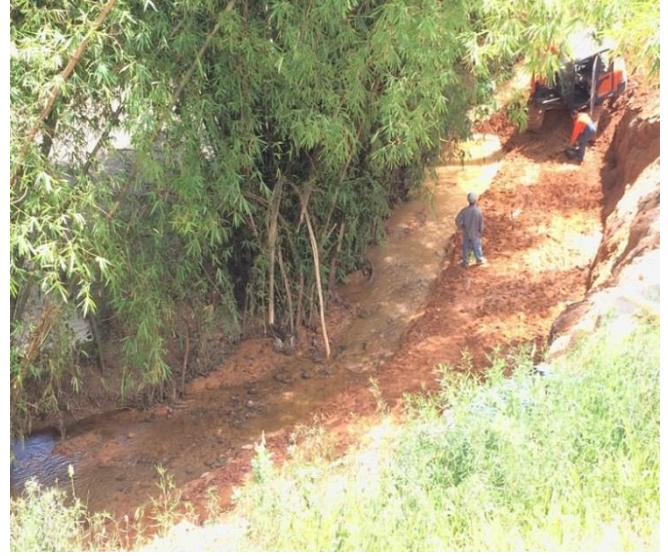
Figura 63 – Corte e retirada de terra no pé do talude.
