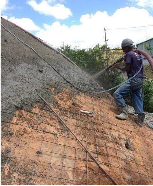
Figura 75 – Execução do concreto projetado do solo-grampeado no talude.
