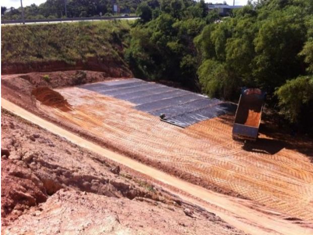
Figura 49 – Aplicação da primeira camada de manta geotêxtil - Intercalando com o aterro compactado.
