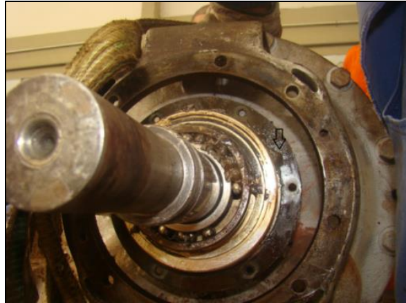
Figura 1. Rolamentos autocompensadores de esfera danificados
