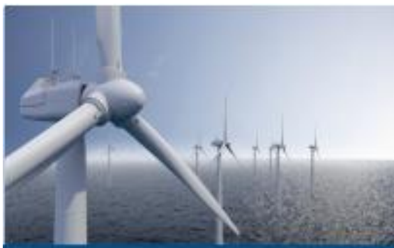
Figura 12 – Parque eólico offshore
