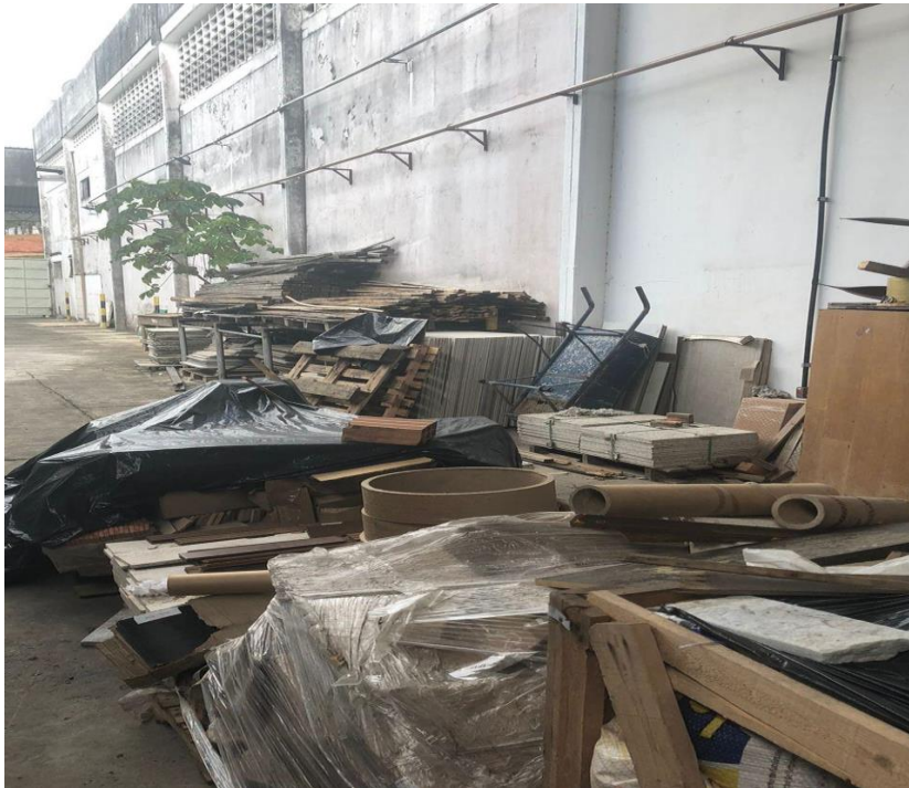
Figura 31. Más condições de armazenamento - parte 3
