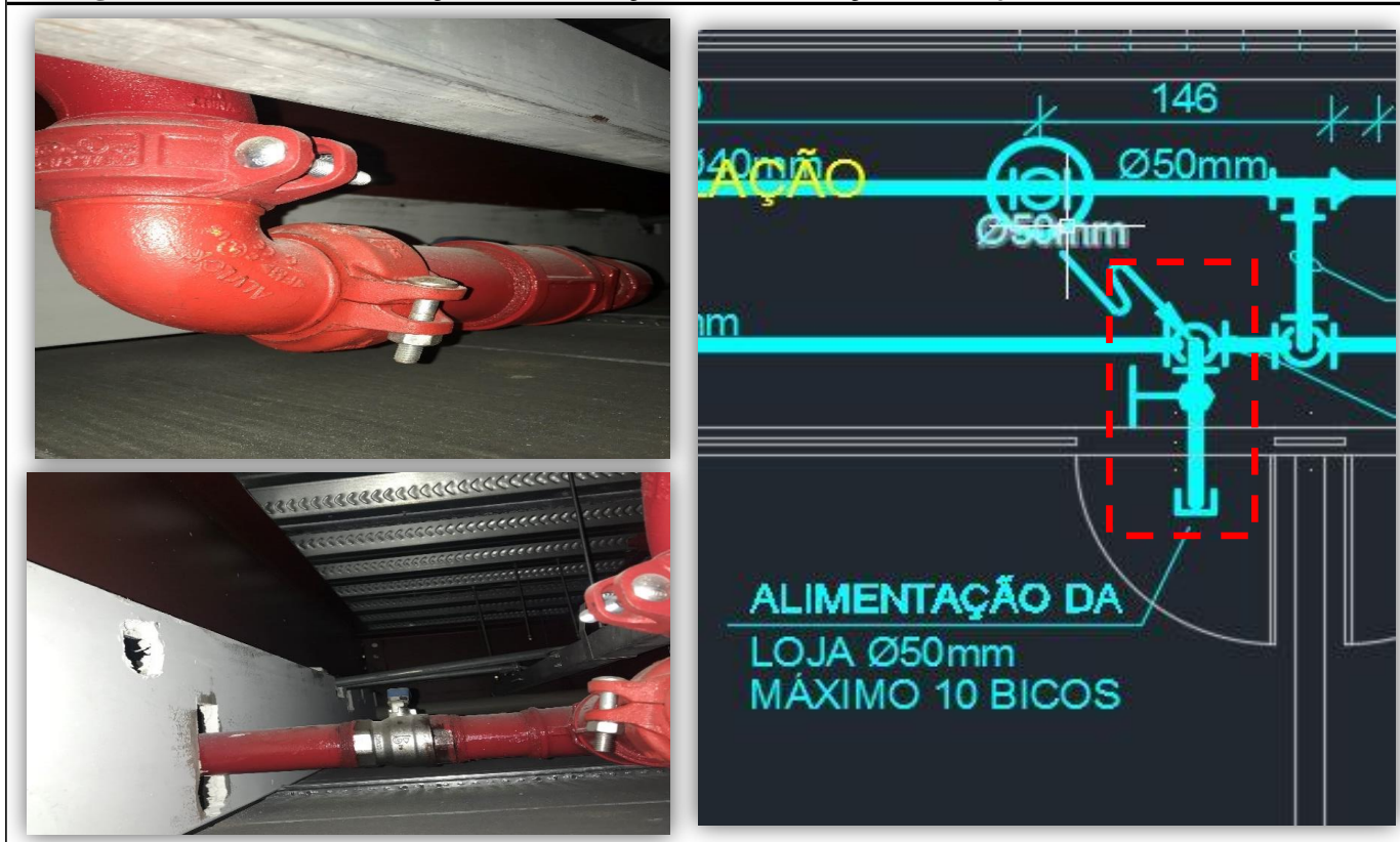
Figuras 17 e 18 - Localização de Tubulação de Alimentação das Lojas - (Embutida no Forro)
