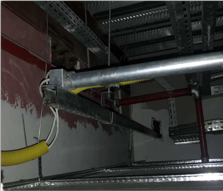
Figuras 15 e 16 - Encaminhamento de Ramal de SPK - (Embutido no Forro)
