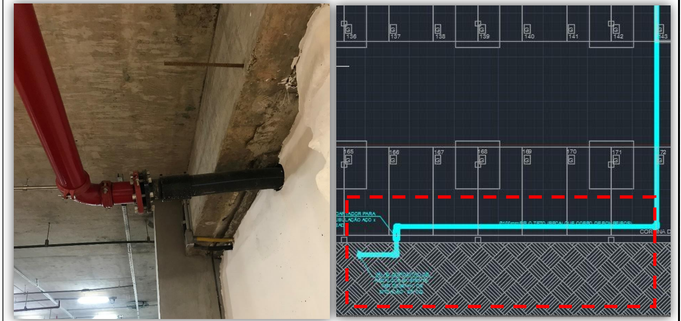
Figuras 1 e 2 - Ramal de Interligação com Tubulação PEAD - (Aparente)
