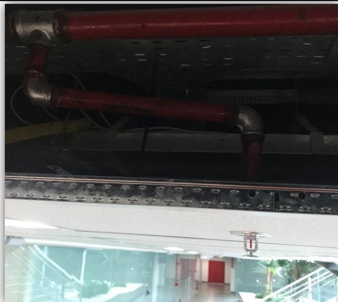
Figuras 13 e 14 - Representação de Desnível em Tubulação Embutida no Forro - (Embutido no Forro)
