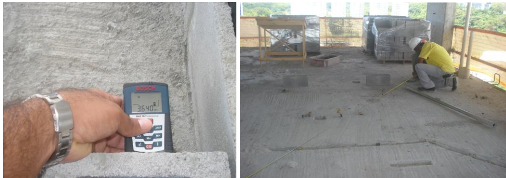
Figura 9 – Conferência das cotas através da treina a laser e do esquadro de marcação
