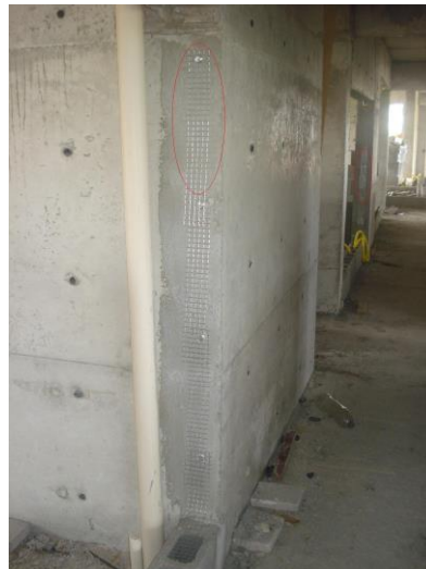
Figura 3 – Tela Metálica para amarração alvenaria/estrutura
