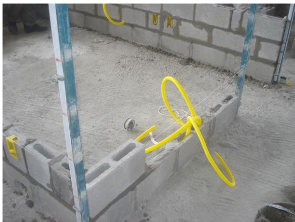
Figura 4 – Elevação da 2ª fiada com auxílio do escantilhão
