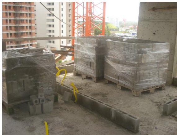
Figura 8 – Armazenamento dos paletes no local de trabalho
