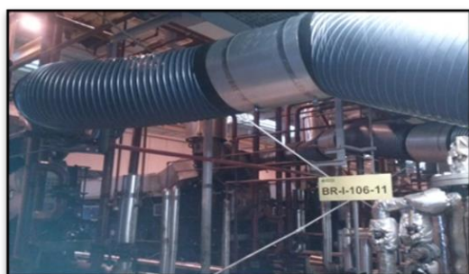
Figura 08-Duto flexível instalado.
