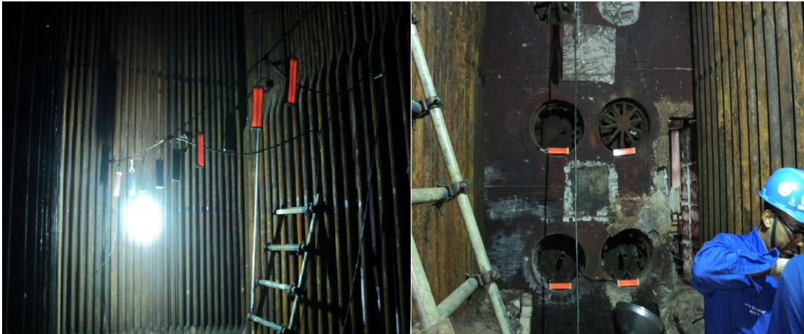
Figuras 20 a) e b) – Disposição das resistências dentro da caldeira
