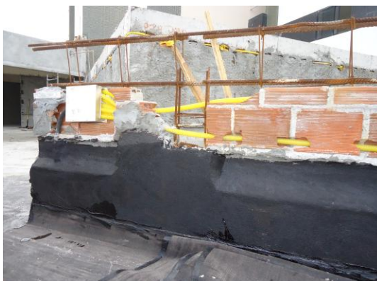
Foto 5.15 – Execução de impermeabilização antes de serviços de estrutura e alvenaria
