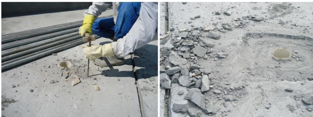
Foto 5.13 – Execução de rebaixo após regularização de toda a laje externa
