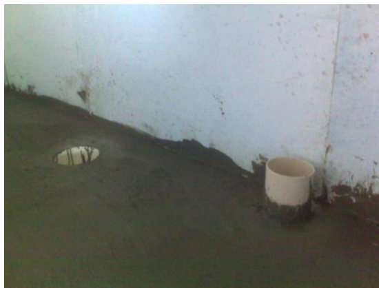
Foto 5.7 – Tubos passantes próximos à parede
