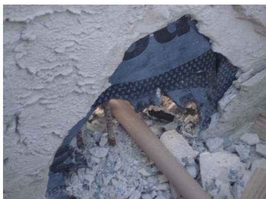
Foto 5.8 – Perfuração da impermeabilização para passagem de tubulação de água
