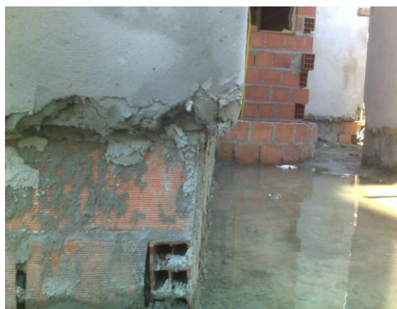
Foto 5.11 – Espessura do revestimento em paredes externas
