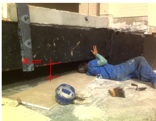
Foto 5.3 – Aplicação da impermeabilização numa junta estrutural
