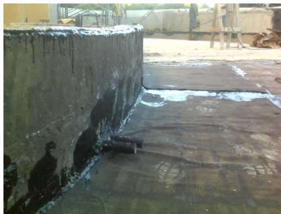
Foto 5.6 – Tubos passantes próximos à laje
