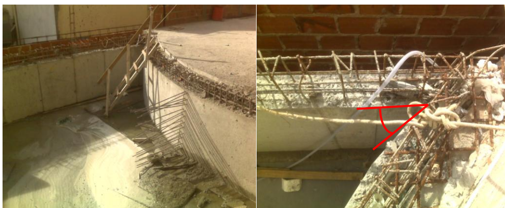
Foto 5.4 – Detalhe de uma piscina em concreto
