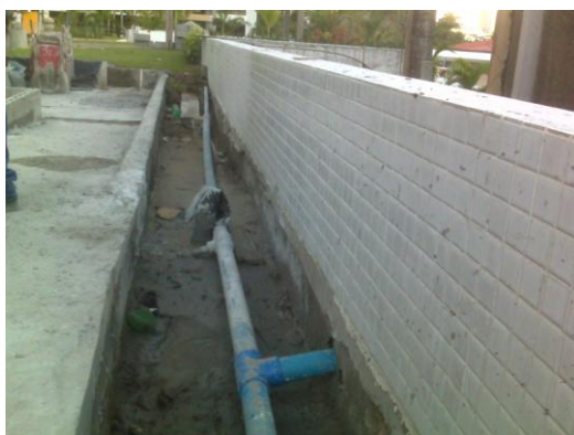
Foto 5.9 – Instalação do sistema de irrigação após a instalação da impermeabilização
