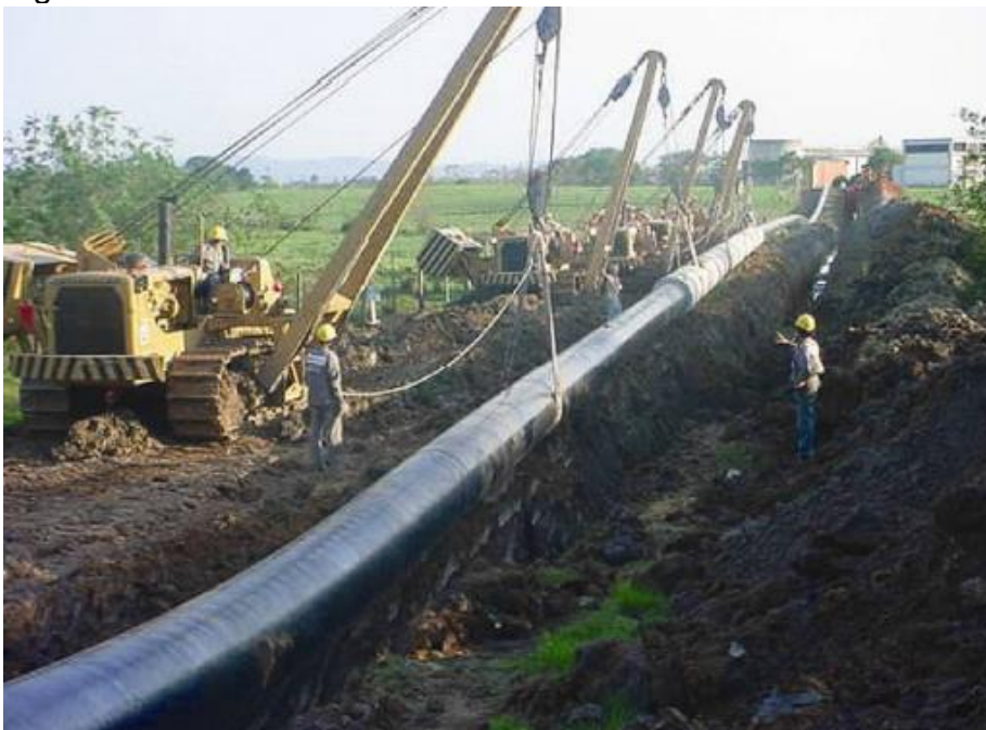
Figura 6. Duto terrestre sendo rebaixado
