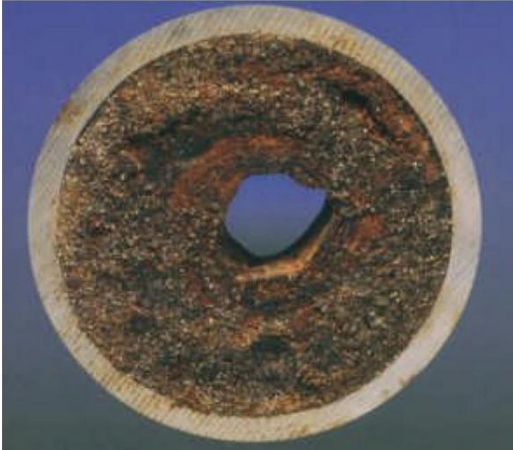
Figura 15. Deposição de parafina na tubulação
